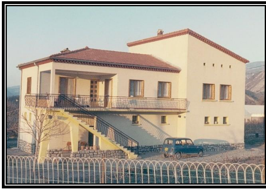
La maison neuve de la Curnerie construite par le copain architecte Pellenc
