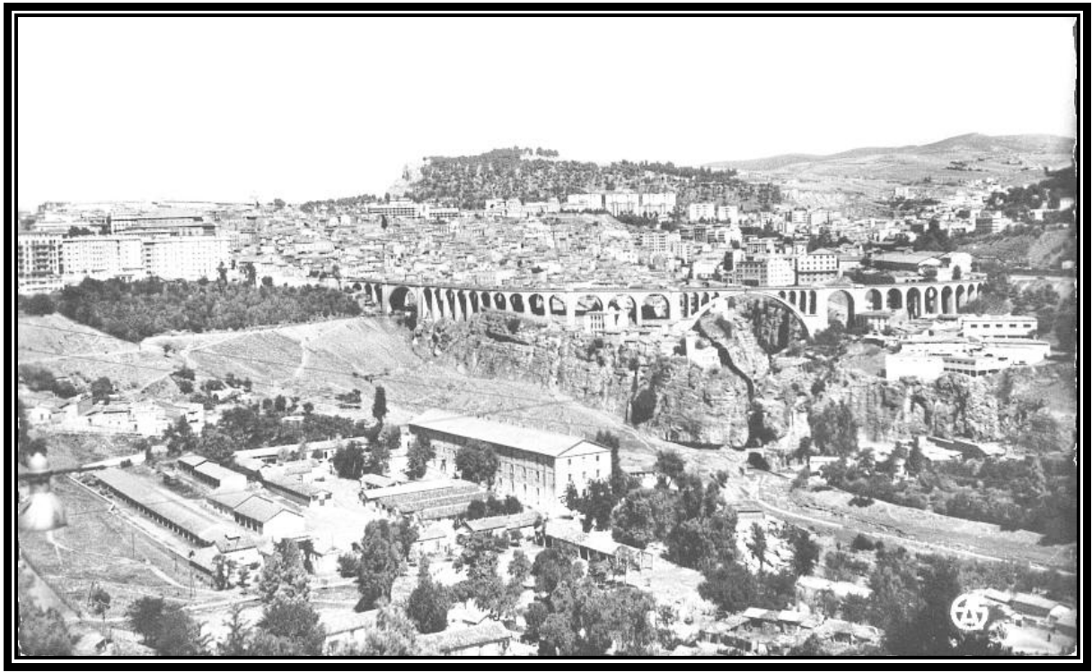
Constantine, vue générale, le pont Sidi Rached
